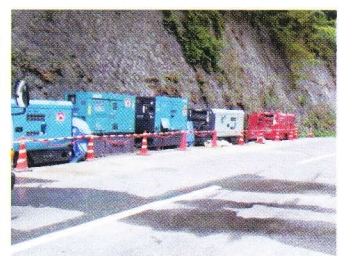
↑ 大型動力は遠隔配置
